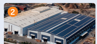
Mahabubnagar Unit-IV, Telangana
